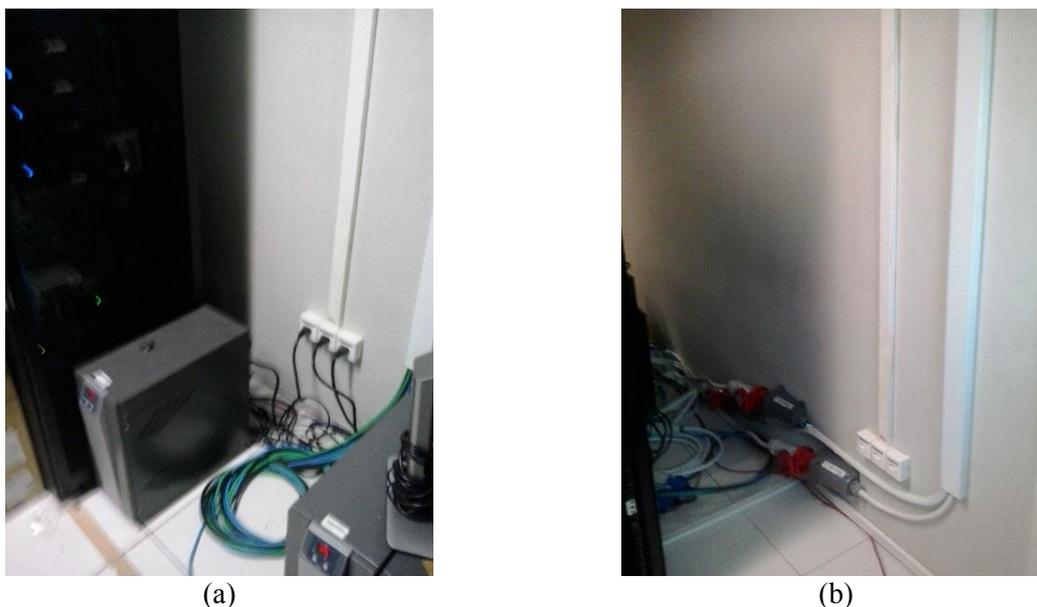
**Figura 04** – Instalações dos circuitos elétricos de alimentações dos nobreaks de 10 kVA
